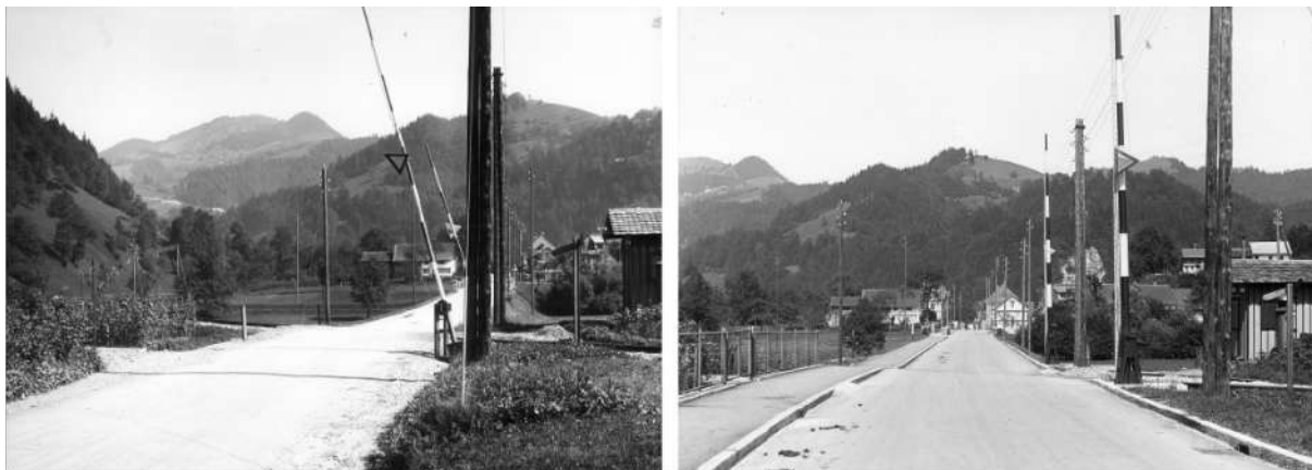
Abbildung 3.4: Die Strasse wird besser befestigt: Bahnübergang Schmittbach in Fischenthal vor (links) und nach Modernisierung in den Dreissigerjahren(rechts) [2]
