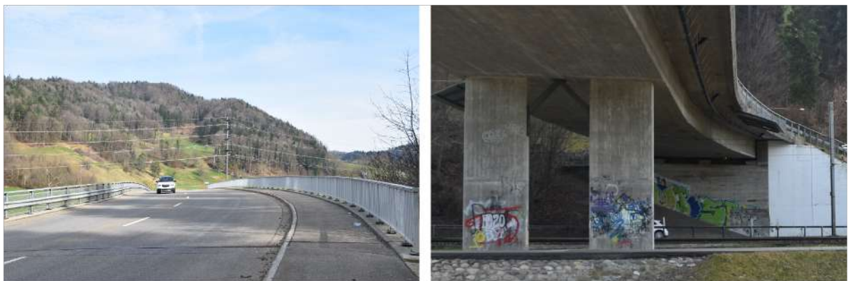
Abbildung 5.16: Heutige Markierung auf der Brücke (links) und mit Hohlkastenträger monolithisch verbundener Mittelpfeiler (rechts).
