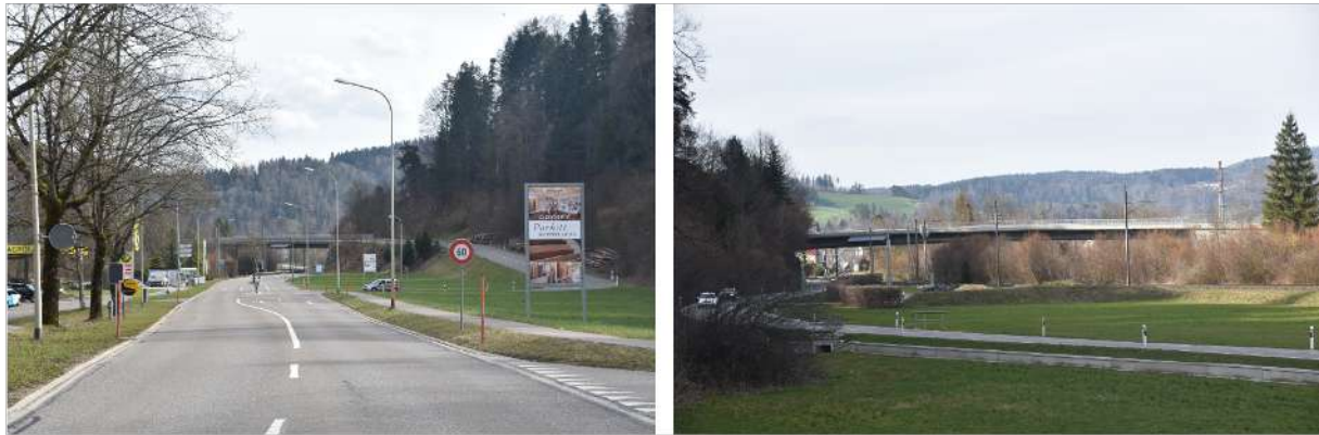
Abbildung 5.15: Abbiegesituation Tösstalstrasse / Strasse nach Tablat (links) und Ansicht von Saland her (rechts)
