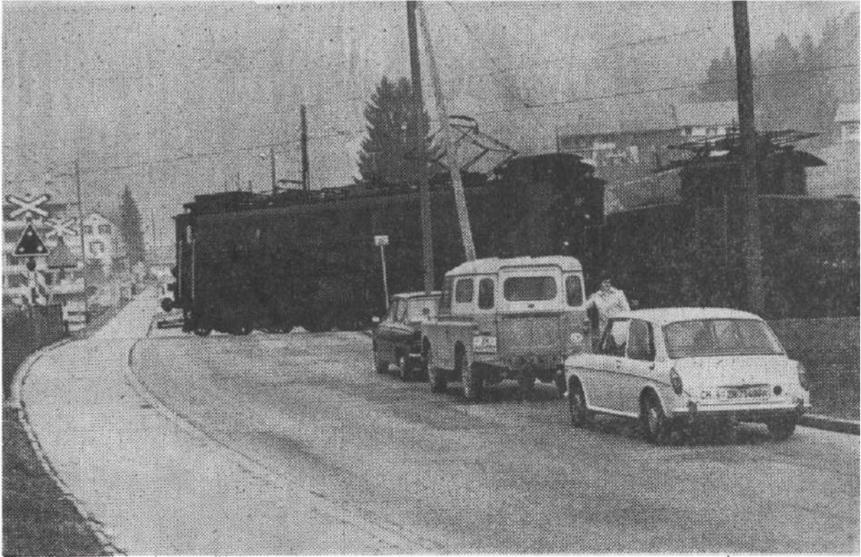
Abbildung 3.7: Berüchtigter Bahnübergang Schmittenbach, welcher von den SBB zuerst von einer handbetriebenen Barrierenanlage zu einem Wechselblinker umgerüstet wurde und dann schliesslich durch einen Unterföhrungsbau ersetzt wurde [78].
