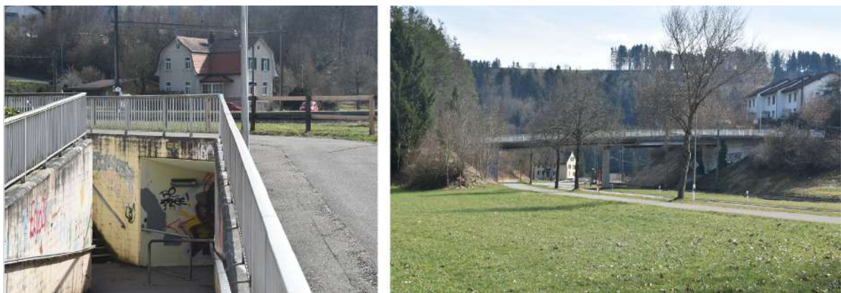
Abbildung 5.10: Unterführung als Fussgänger:innenzugang zum Bahnhof Rämismühle-Zell (links) und Überführung als Verbindungsstrasse zwischen Rämismühle und Zell. Der Standort des Fotografs ist in Abbildung 5.7 mit einem grauen bzw. hellblauen Pfeil gekennzeichnet.
