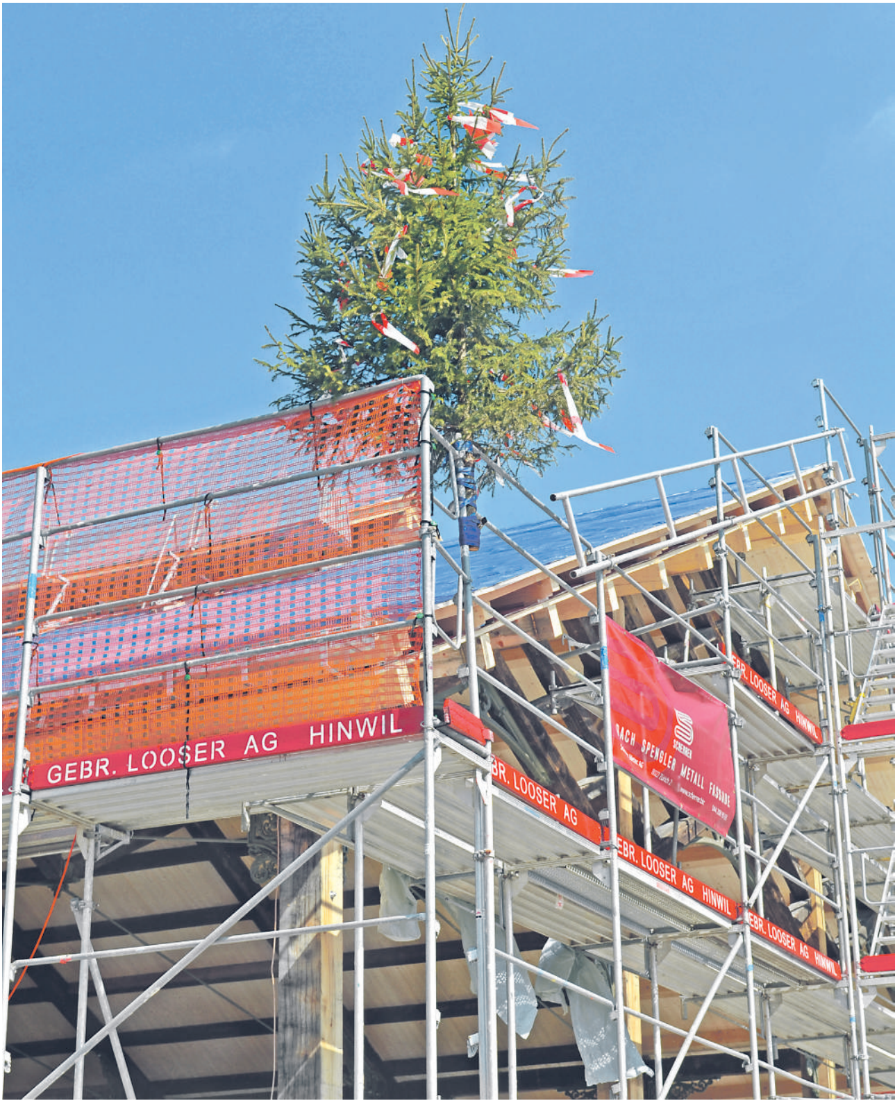
Das Aufrichtebäumchen deutet es an: Die Bahnhofshalle in Bauma ist bald bezugsbereit Foto: pa
