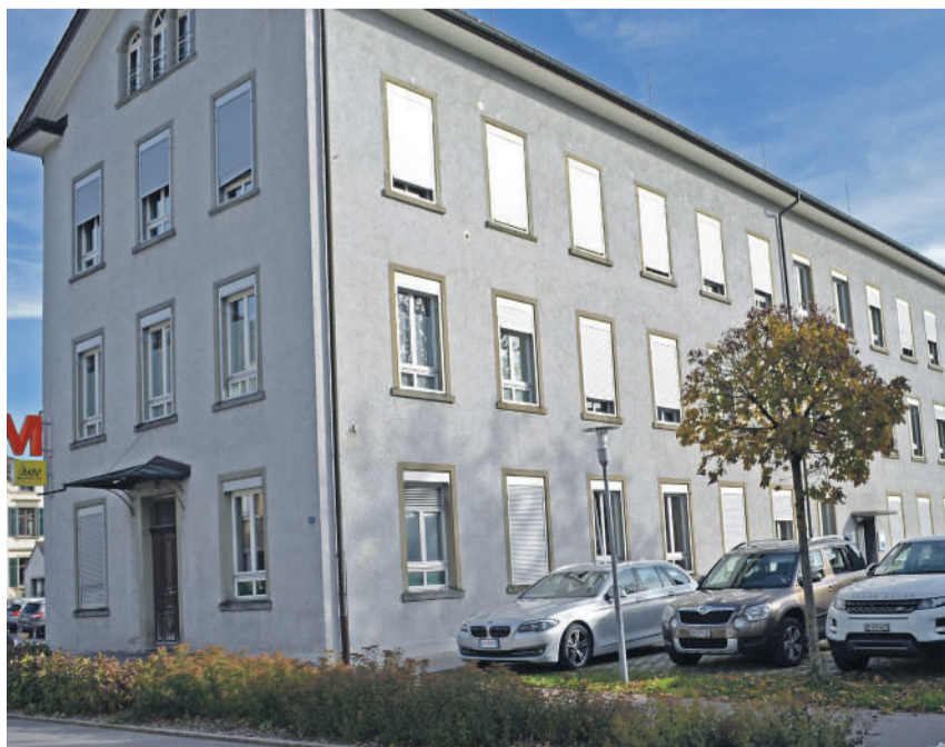
Mitten im Dorf: die Stickerei von Hauptmann Jakob Schaufelberger, erst zweistöckig, dann aufgestockt, heute Migros
