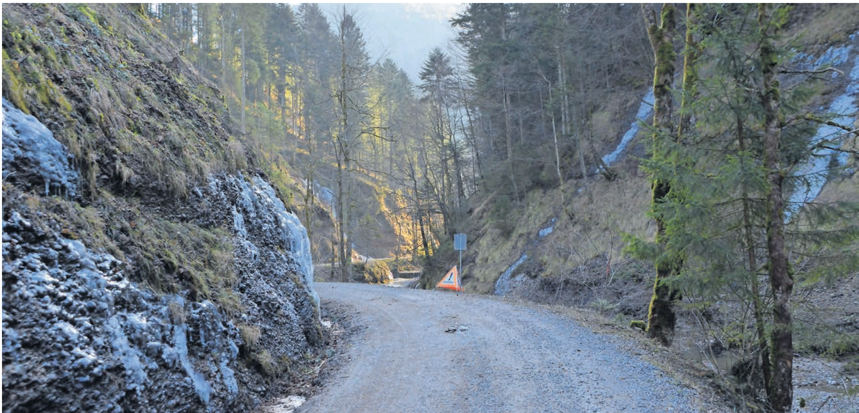
Hier etwa wäre man vor einer 50 Meter hohen Staumauer gestanden
